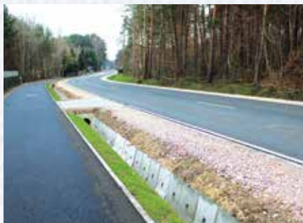
Ukończona droga 1515W w miejscowościach Budy Grzybek (gmina Jaktorów), Czarny Las i Makówka (gmina Grodzisk Mazowiecki).
