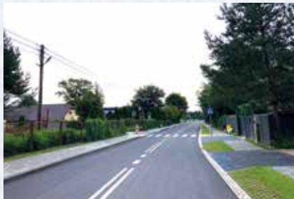
Ukończona droga 1508W w Chlebni (gmina Grodzisk Mazowiecki).
